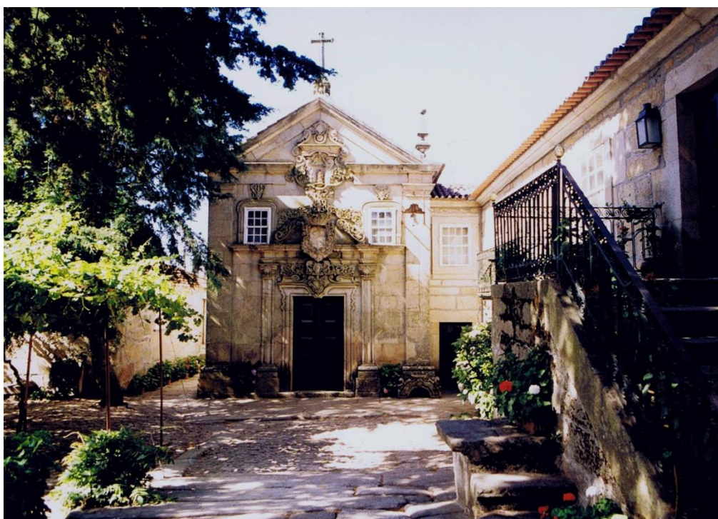
Fig. 2 - Capela dos Santos Mártires na Casa da Torre das Pedras
